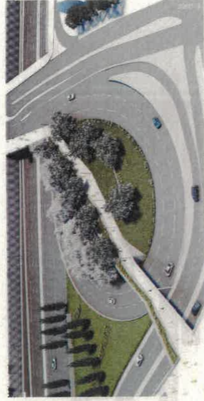
Future passerelle du pont de Nogent.
