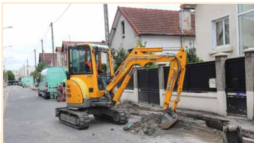
Enfouissement des réseaux ↓
