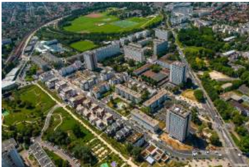
Figure 8 : vue aérienne de la pointe Aviateurs
