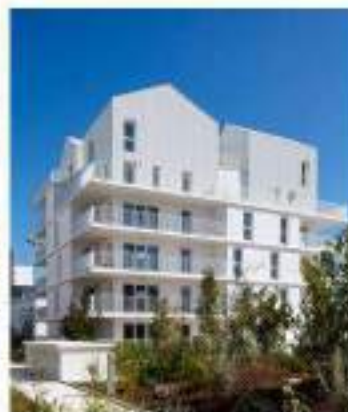
TOITURDS EN PENTE CONTEMPORAINES Biarritz (arch: B&B)
