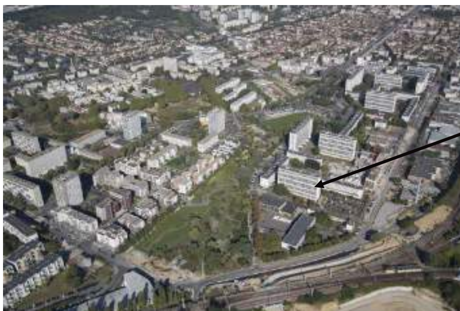
Figure 6 : vue aérienne du secteur Navigateurs sud
