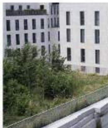
PLANTATION EXTENSIVE D'UNE TERRASSE ACCESSIBLE, Biologie Biarritz - Hotel de la Méditerranée (arch: Charlier d'Albi)
