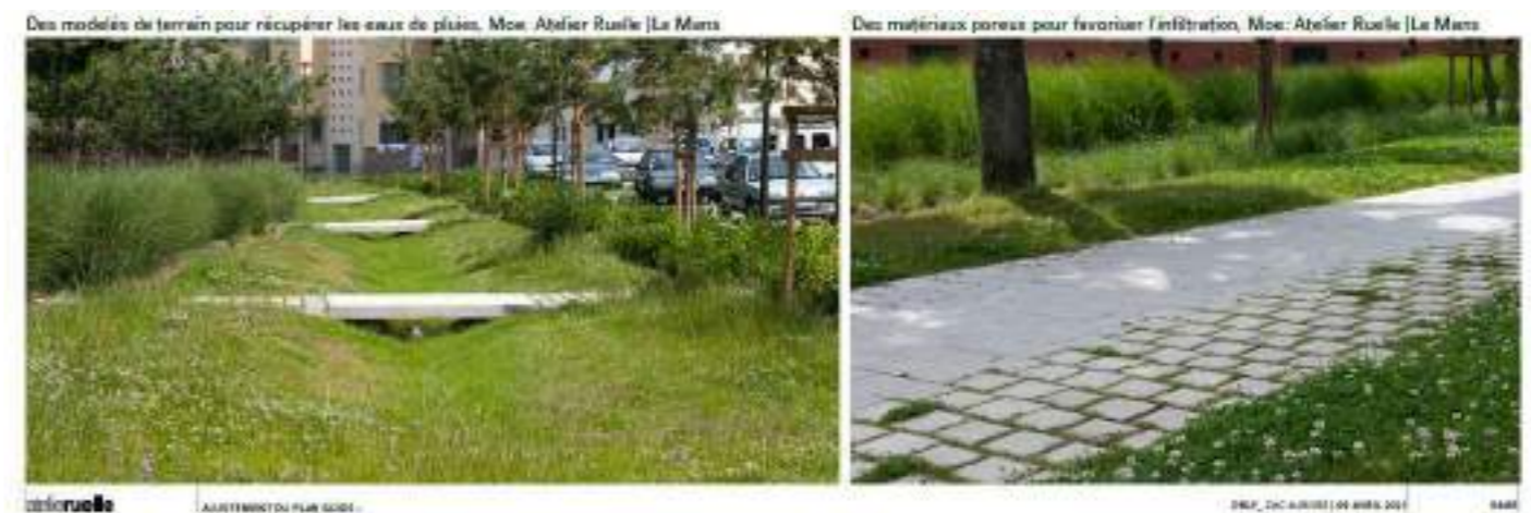
Figure 23 : Exemple de gestion alternative des eaux pluviales - Source : Plan Guide, Atelier Ruelle
