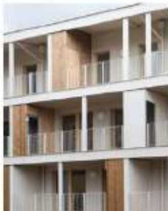
DES CHAUSSES COMME PAREIS DE DEPARTEMENTS VOISINS ET ESPACES DE BAINEMENT EXTENSIF CACHE S Wilo Astoria (arch: Eclair + Hagnin architectes)
