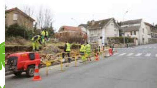
8. Allée du Lac/avenue de l'Aérodrome En cours : création d'un parking de 11 places, comprenant 1 place pour personnes à mobilité réduite.
