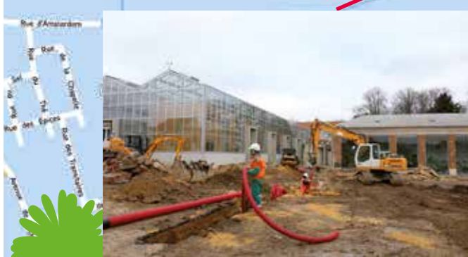
10. L'Orangerie En cours : création d'un parking de 29 places, comprenant 3 places pour personnes à mobilité réduite et un parking pour 2 roues. A l'automne, 9 arbres, 358 arbustes, 22 plantes grimpantes, 1966 graminées et 498 plantes vivaces seront plantés et 250 m2 d'espaces verts aménagés. Ce chantier est la 1ère phase de la requalification du Parc Méliès.
