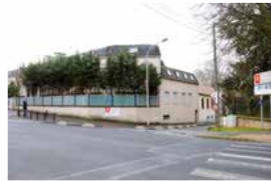
2. Rue Louis Bonin/avenue de la Victoire Déjà réalisé : 8 bornes anti-stationnement.
