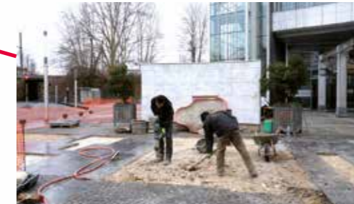
7. Place François Mitterrand En cours : réfection partielle de la place avec remise en état des pavés.
