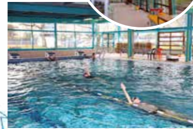
3. Piscine Léon Truyns Déjà réalisé : remise en état des verrières et des façades vitrées.
