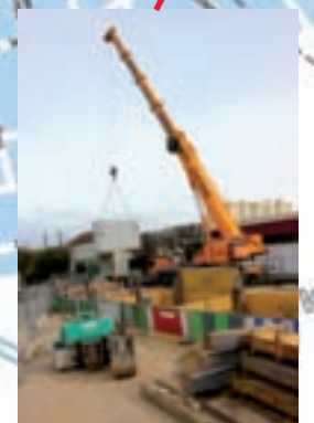
9. Gare d'Orly ville Déjà réalisé : Pose des bassins de réservoir et de rétention. A venir : Création d'une voie de bus, puis l'installation du bassin d'agrément qui sera paré de jardinières, cascades et jets. Fin des travaux : Octobre
