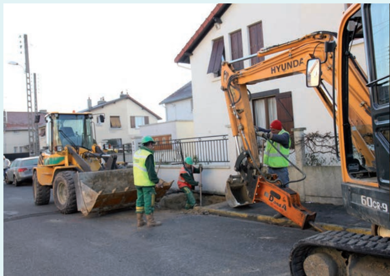
L'aménagement des voiries à la Cité-Jardins Les travaux d'assainissement ont commencé à la Cité-Jardins.
