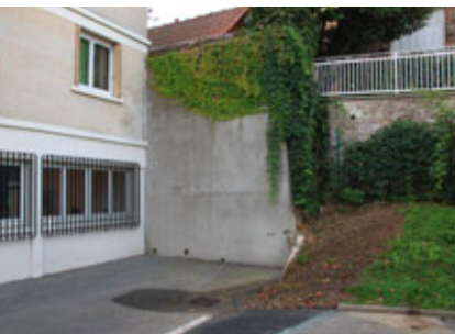
La ville a démolit le muret pour améliorer le confort des habitants de la Résidence des Tourelles.
