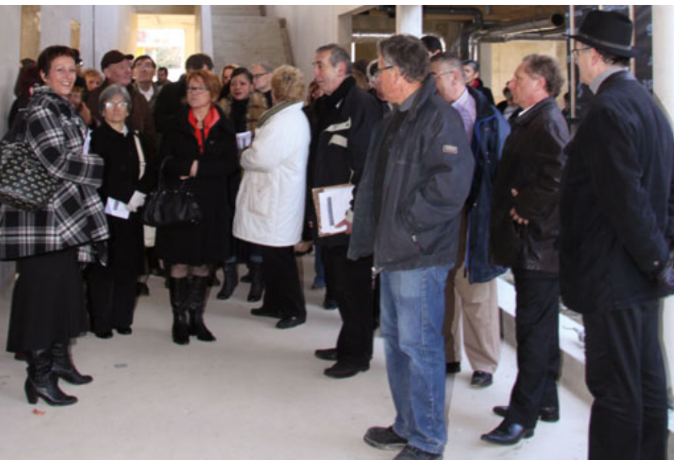
Visite de chantiers samedi 20 novembre : les élus découvrent le futur accueil de loisirs maternel à la Pierre au Prêtre.
