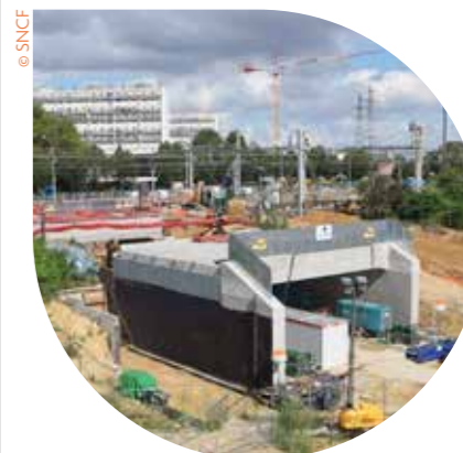
Travaux réalisés durant l'été pour permettre le passage du futur Tram 9 sous les voies.
